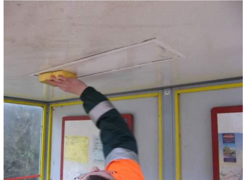
Nettoyage du plafond
