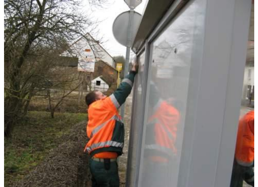
Nettoyage des parois
