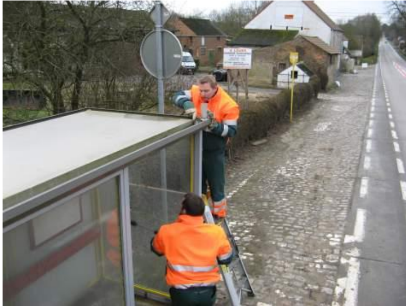
Nettoyage des corniches
