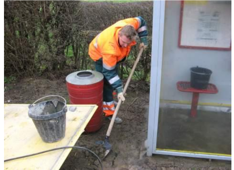
Nettoyage des abords
