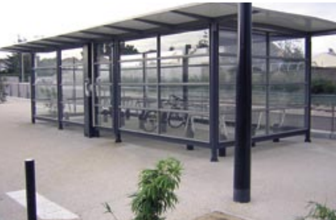
VUE – " la station des Pas enchantés " dispose d'un parking vélo couvert et fermé.
