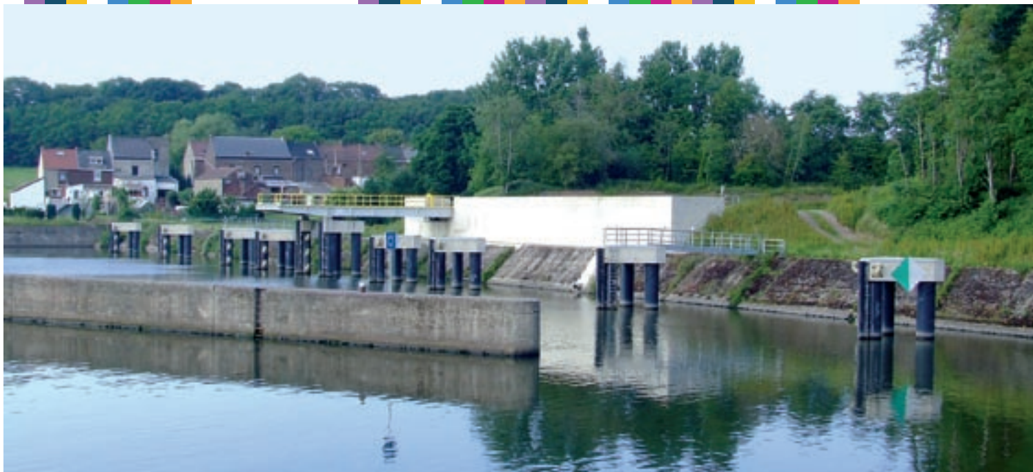
Nouveau quai de chargement en bord de Sambre à Auvélais (Sambreville). Source : ICEDD.
