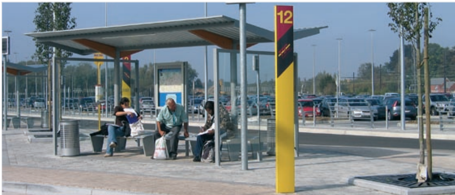
Nouvelle gare des bus et parking de la gare de Gembloux. Source : ICEDD.
