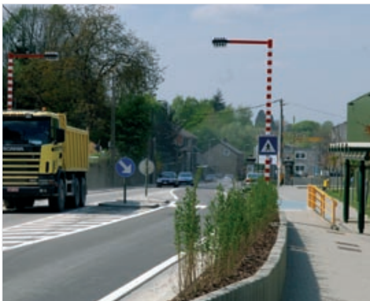
Sprimont : sécurisation de passage piéton. Source : SPW – Direction de l'Édition.
