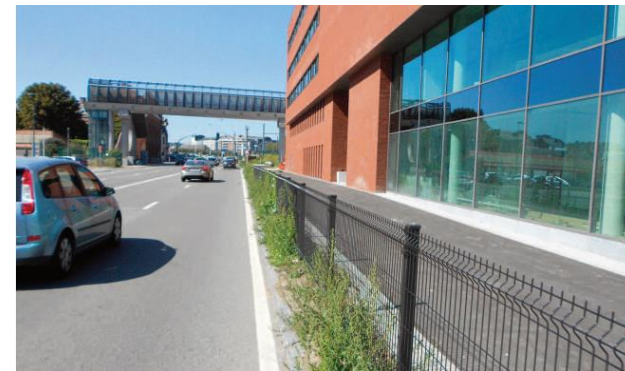
Bd Cauchy "Archives de l'Etat", chantier Thomas et Piron avec réalisation d'un tronçon de RAVeL urbain en charge d'urbanisme
