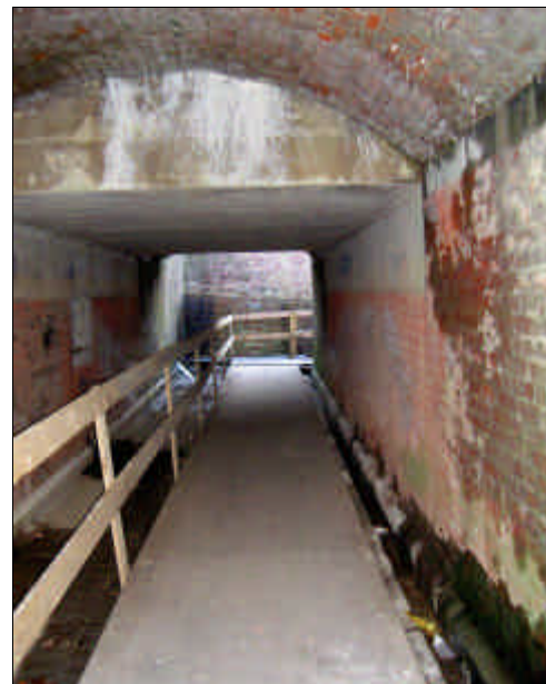
Figure 2 - Le passage souterrain à la gare de Bovesse
