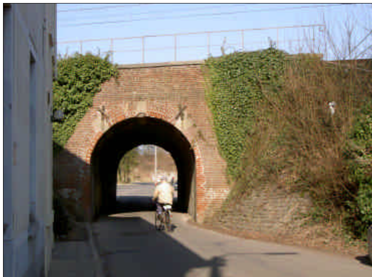
Figure 1 - Le passage sous les voies ferrées vers le stade de Gembloux (rue Victor Debecker)
