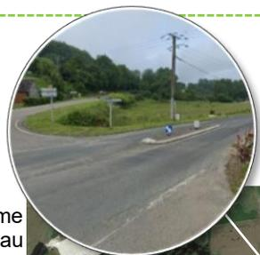
Elément physique (ici berme centrale surélevée) présent au centre de la voirie de manière à appeler à la vigilance et éviter notamment que des automobilistes ne coupent trop le virage lors d'une insertion / sortie de la chaussée de Wavre.
