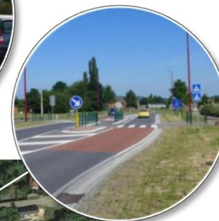
Sécurisation du carrefour avec un aménagement central physique, auquel est associé une traversée piétonne avec éclairage particulier et, potentiellement, un feu à la demande. Un dévoiement léger est ainsi créé, contribuant à l'apaisement de la circulation.
