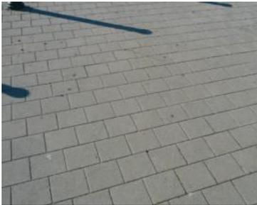
Figure 4 : Revêtement modulaire en dalles de béton
