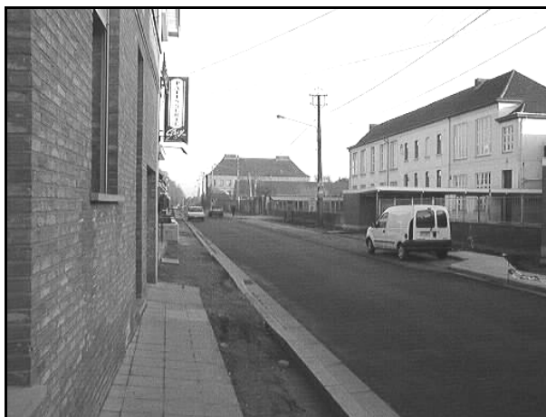
La rue O. Lhoir en réfection
