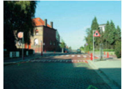
Objectif 1. Promenade urbaine. Sécurisation des carrefours et création de pistes cyclables. Situations avant et après travaux. Source : Ville de Mouscron
