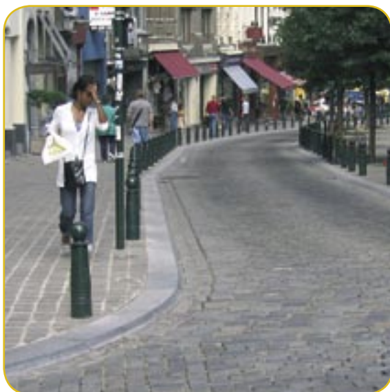
Vue : trottoirs équipés « anti-stationnement », rue de la Madeleine à Bruxelles.
