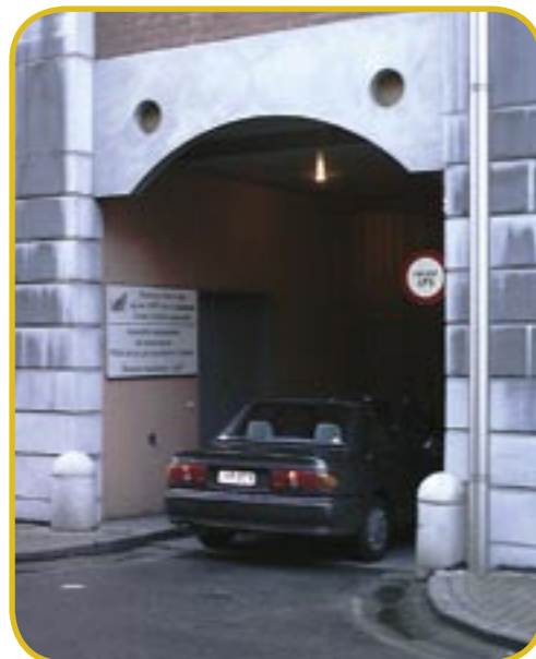
Vue : Jambes, parking réservé au personnel de l'Administration.
