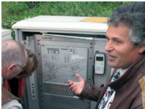
Lausanne : système de priorisation du trafic (relais électronique) – Source : Benoit Dupriez
