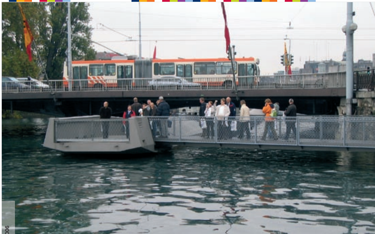
« De la voiture... à la mobilité douce » : nouvelle passerelle piétonne sous un pont routier, Genève – Source : Claude Henrion
