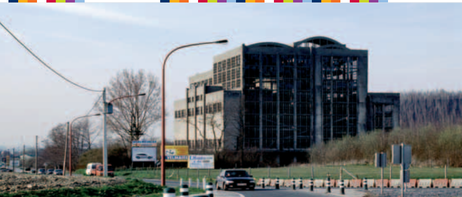
La restauration des sites d'activités désaffectés est inscrite comme une priorité dans la politique de la Région. Cet ancien bâtiment industriel, situé à l'entrée de Perennes-lez-Binche, doit, en principe et dans un avenir proche, accueillir les « archives de l'Etat ». Source : crédits DGATLP – Fabrice Dor
