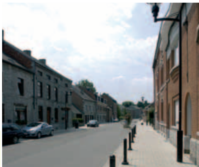
Treignes : aménagements de voirie. Source : MET – D.434
