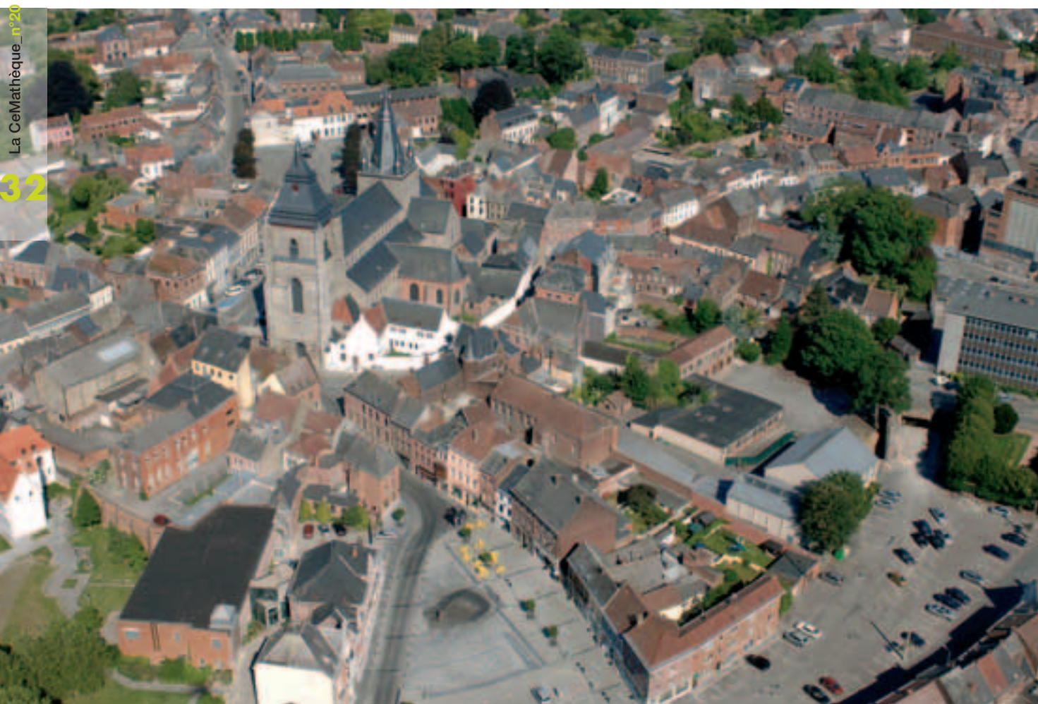
La commune de Soignies dispose d'un schéma de structure depuis 1999 et d'un PCM depuis 2004. Source : Guy Focant. © MRW.
