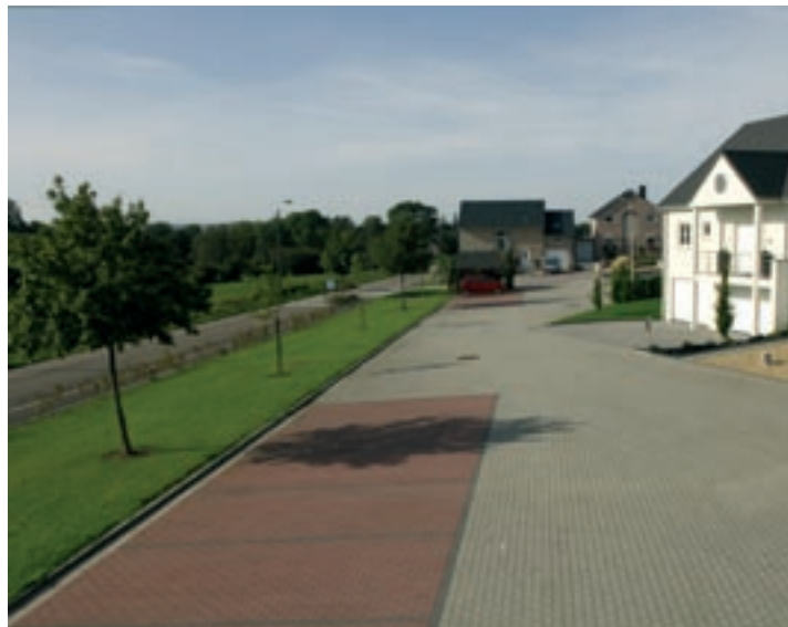
Plombières : ouverture d'une voirie de desserte locale dans un nouveau quartier. Source : MET – D434.
