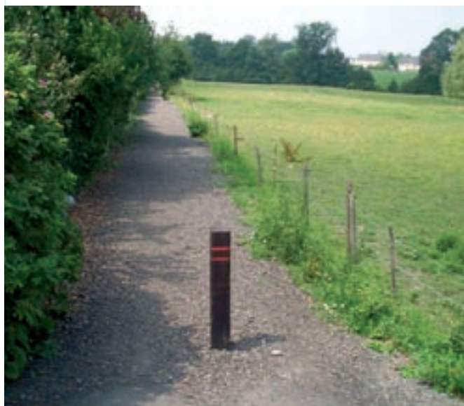
Restriction de passage à l'aide de potelets. Source : Stéphan Poncelet.
