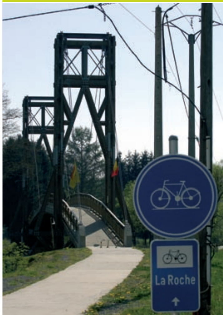
Hotton : aménagement d'un site propre pour les vélos. Source : MET – D.434.
