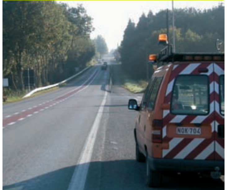
À Durbuy, les mesures de recalibrage et de marquage sur la N983 ont contribué à une réduction de la vitesse. Source : MET – D112.
