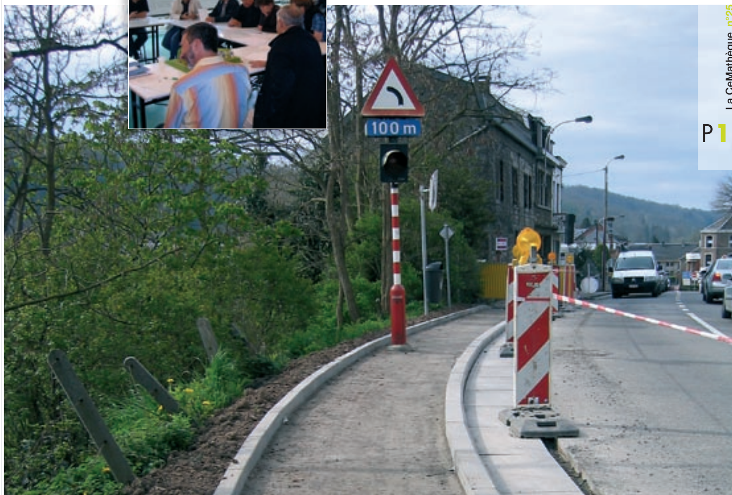
Hamoir : aménagement de trottoir en vue de «confortabiliser» le cheminement piéton. Source : ICEDD.
