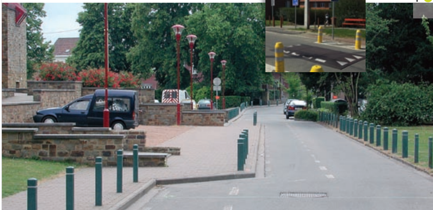
En bas : Jambes, dévoiement de la chaussée qui longe l'école et les lieux d'activités culturelles situés aux abords du parc. Source : ICEDD. En haut : Fleurus, sécurisation de la voirie avec la pose d'un coussin berlinois. Source : SPW, Direction de l'Édition.
