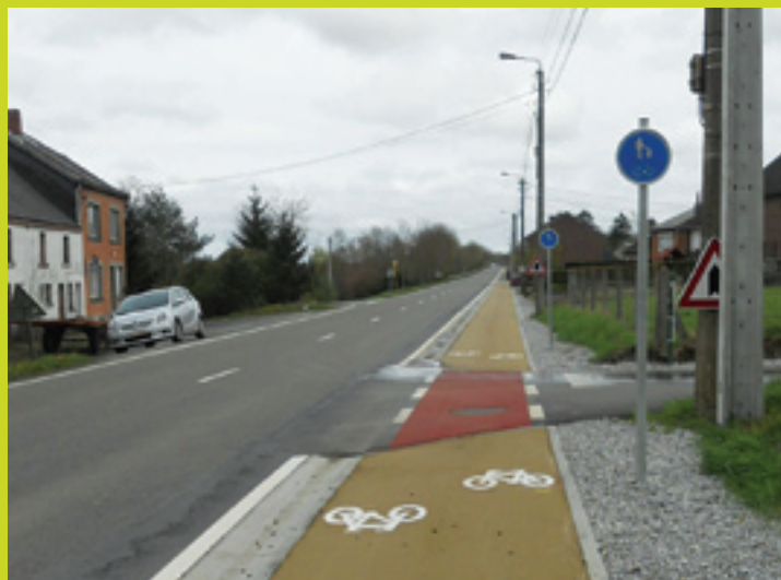
Marche-en-Famenne : piste cyclable avec marquage spécifique en croisement de voirie. Source : PCC de Marche-en-Famenne.
