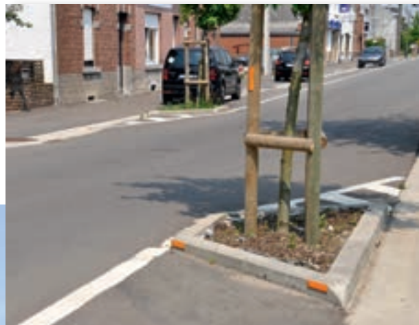
Dispositifs de ralentissement. Clavier : décrochement, Mehaigne : effet de porte à l'entrée du village (rétrécissement, végétalisation et signalétique). Source : ICEDD.
