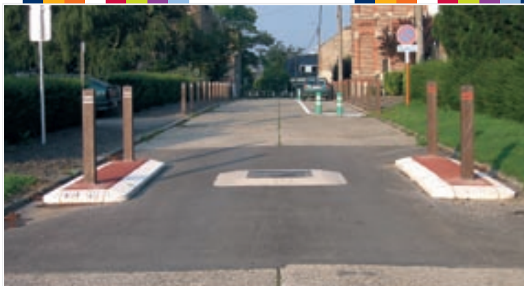
Cognelée : aménagement de « coussin berlinois » en zone 30 abords d'école. Source : ICEDD
