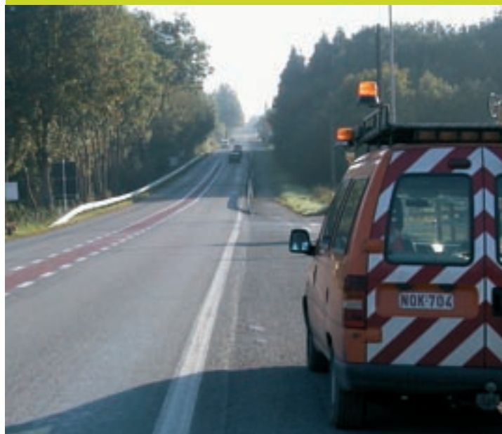
À Durbuy, les mesures de recalibrage et de marquage sur la N983 ont contribué à une réduction de la vitesse. Source : MET – D112.
