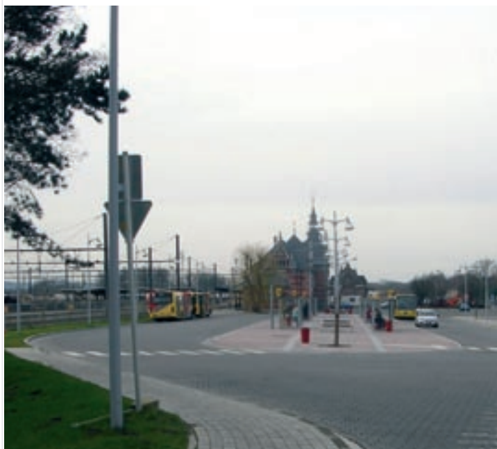
Saint-Ghislain : aménagements de la gare des bus. Source : SRWT.
