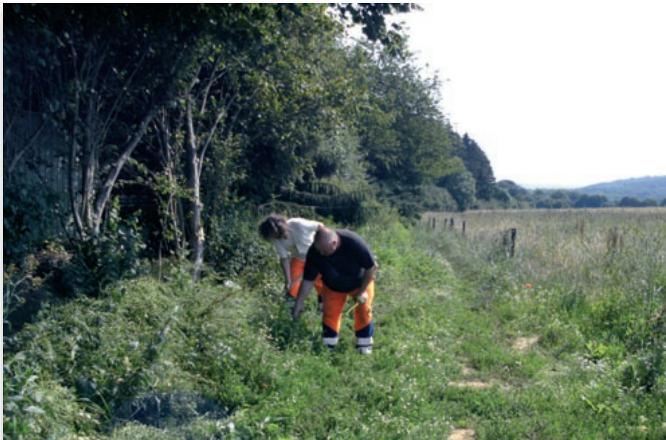
Action d'entretien de chemin communal. Source : ecoledelimont.be.
