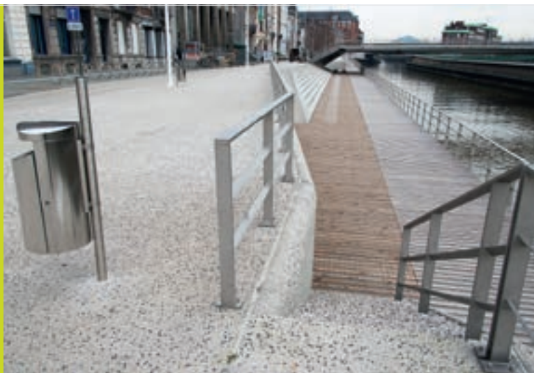
Aménagement des quais et passerelle de Sambre. Source : SPW – Direction de l'Édition.
