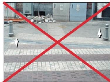
Figure 7: les dalles à protubérances doivent toujours être perpendiculaires à l'axe de la traversée. © GAMAH
