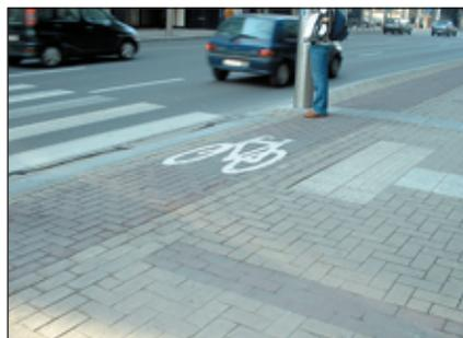
On veillera à ne jamais placer d'avaloirs ni de filets d'eau en demi-lune au niveau des traversées. L'avaloir devra être décalé, et le filet d'eau, remplacé par une bande de contrebutage.
