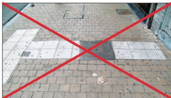
Figure 23 : dalle recouverte d'une plaque d'égout.
