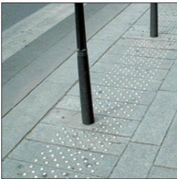
Figure 1: les dalles de type « rivet ».
