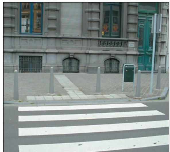
Figures 1 à 3 : implantation type des dalles dans des traversées simples. © GAMAH
