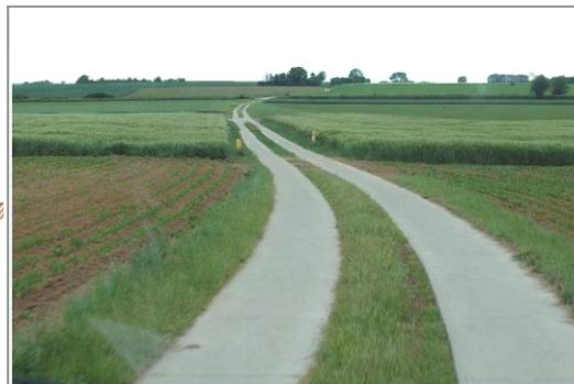
Des intervalles de croisement régulièrement implantés doivent être gérés hors bibandes. Tous les chemins de remembrement du PICM devront faire l'objet d'une fermeture à la circulation hors véhicules agricoles, cavaliers, piétons et cyclistes
