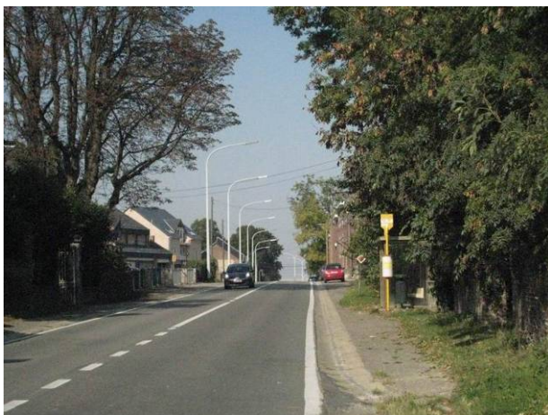
N 64 près de l'arrêt TEC. Pas de trottoir
