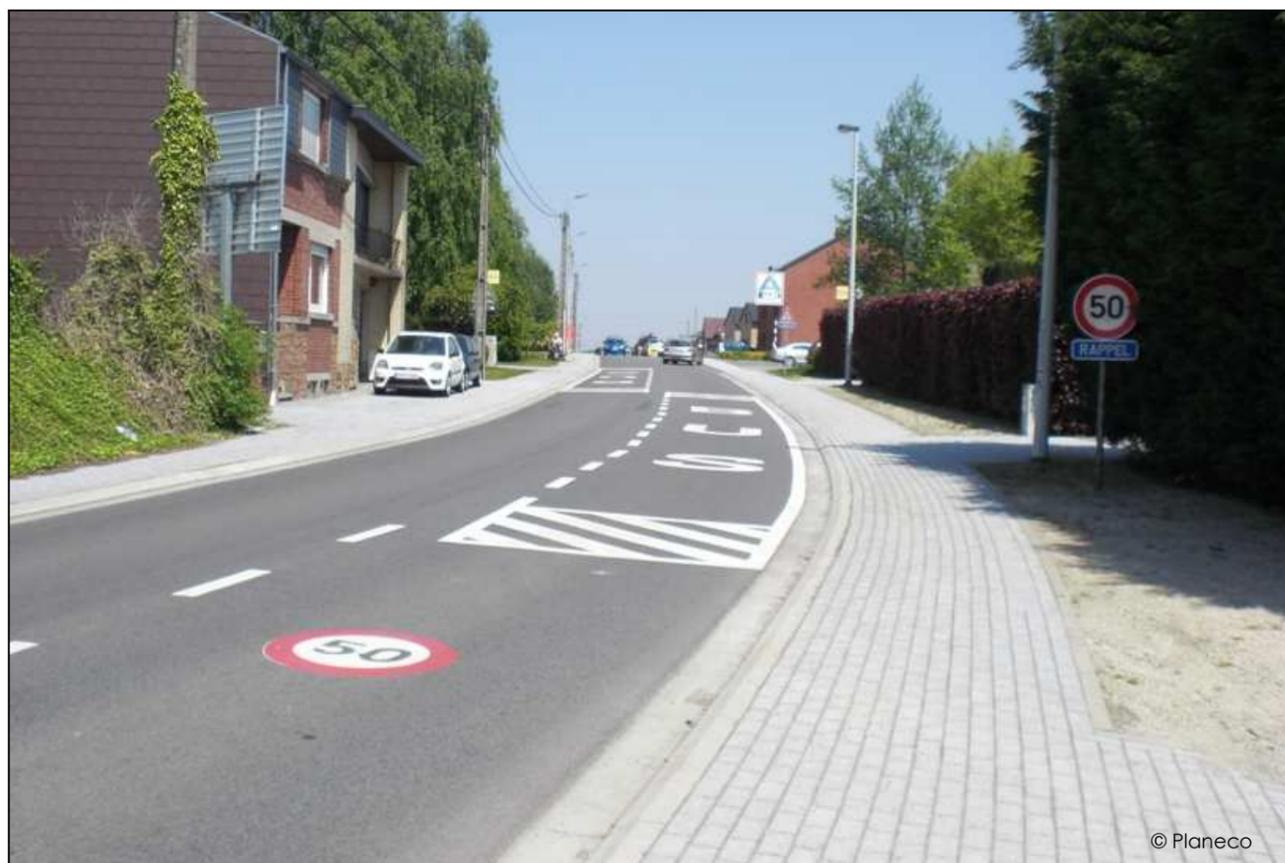
Figure 17. Le trottoir de la rue d'Oupeye à Hognoul a été réaménagé récemment à l'aide de pavés bétons (klinkers) et offre une zone d'attente confortable aux personnes attendant le bus.
