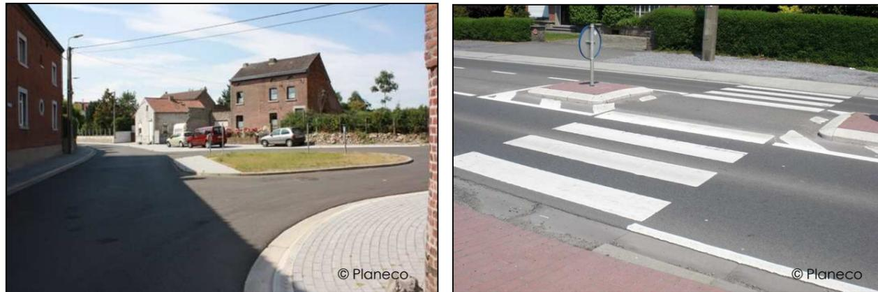
Figure 9. Réaménagements de trottoirs sans abaissement de trottoirs (à gauche, rue Joseph Valleye – voirie communale) et avec abaissement de trottoirs (à droite, N3 – voirie régionale).
