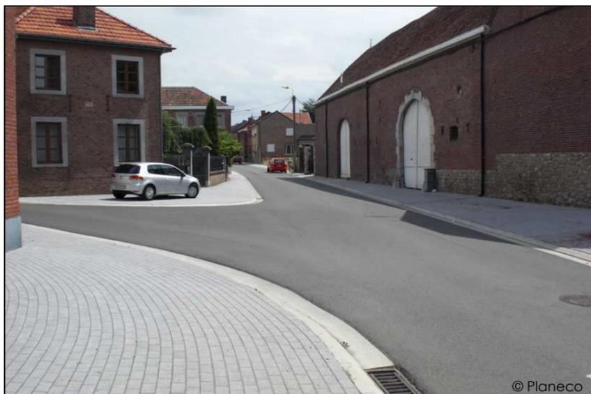
Figure 3. Les pavés bétons légèrement rugueux forment le revêtement des nouveaux trottoirs rue Joseph Dethier (Villers-l'Evêque) : un revêtement de qualité à utiliser lors des renouvellements de trottoirs.
