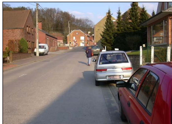
A Pécrot, trottoir utilisé pour du stationnement et piéton obligé de circuler sur la chaussée
