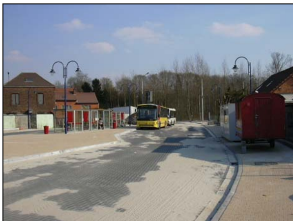
Gare d'autobus de Hamme-Mille – vue générale
