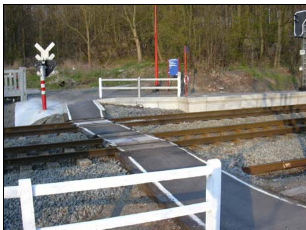
Passage à niveau à la halte de Florival
