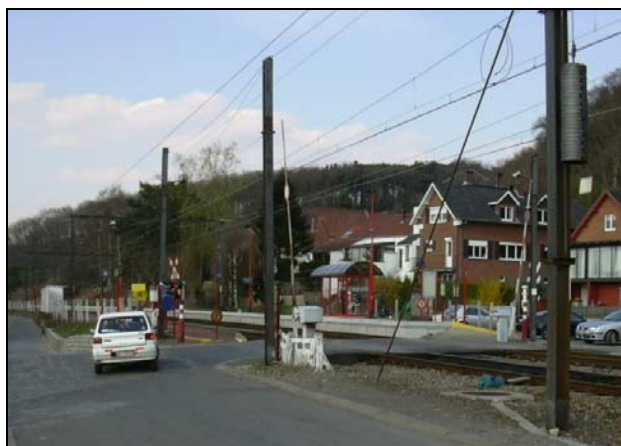
Passage à niveau à la halte de Pécrot
