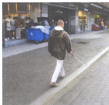
Figure 2 : détection à la canne de la bordure guide
