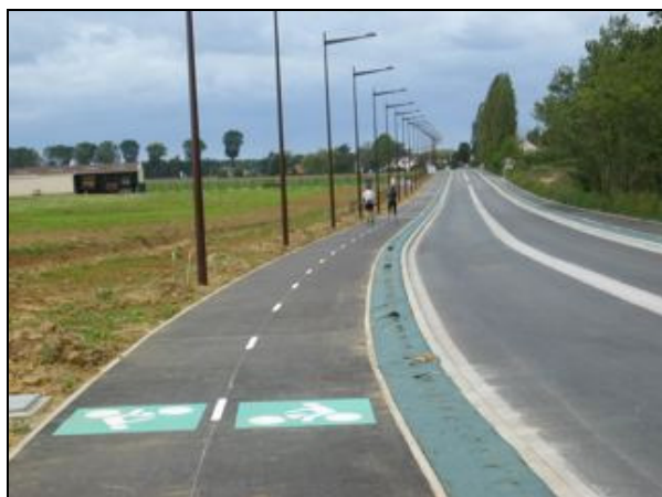
Figure 8 : Photographie, piste cyclable séparée bidirectionnelle
