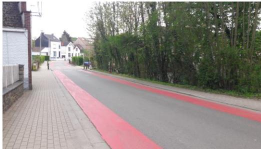
Exemple de voie centrale banalisée (source : SPW – IBSR et ICEDD)
