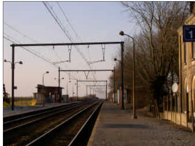
Quais de la gare de Bovesse
