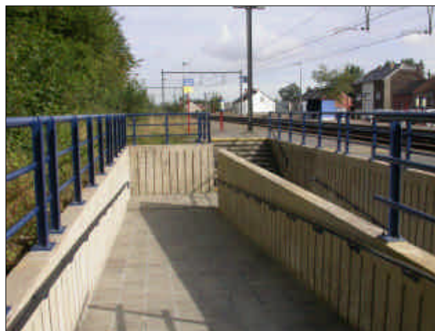
Rampe permettant le passage sous les voies
