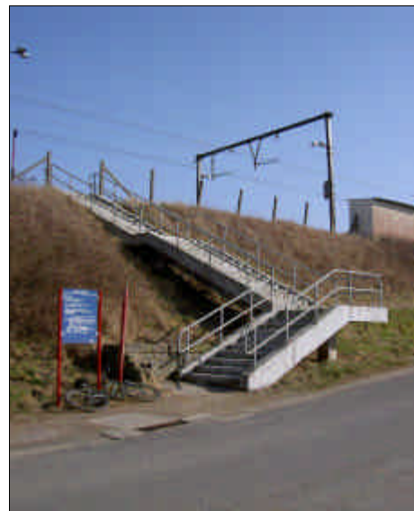
Escalier d'accès au quai
