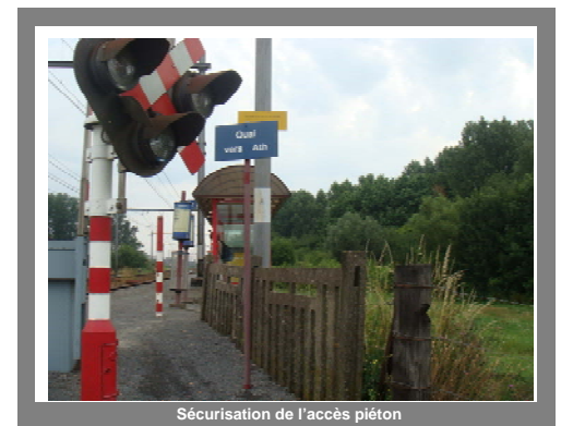
Sécurisation de l'accès piéton
