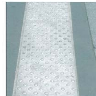
Les dalles collées
