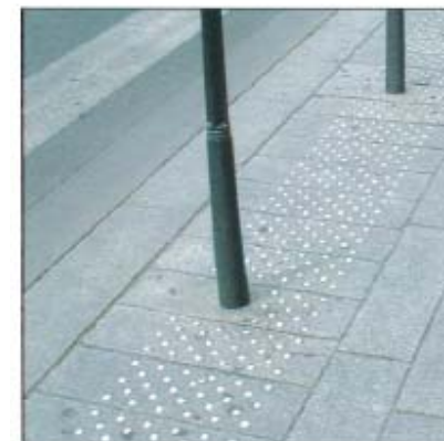
Les dalles de type « rivet »
