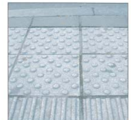
Les dalles de béton
