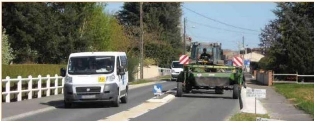
Figure 2 Exemple de chicanes ou bordures franchissables pour engin agricole (source : Charte des circulations agricoles, intégrer les déplacements des véhicules agricoles dans les projets d'aménagement du territoire, Association des maires de Maine-et-Loire, 2013)
