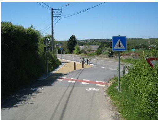
Traitement d'une traversée
