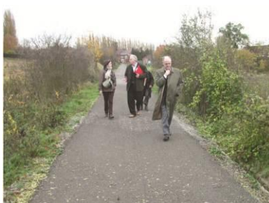
Gravier fin stabilisé au ciment
