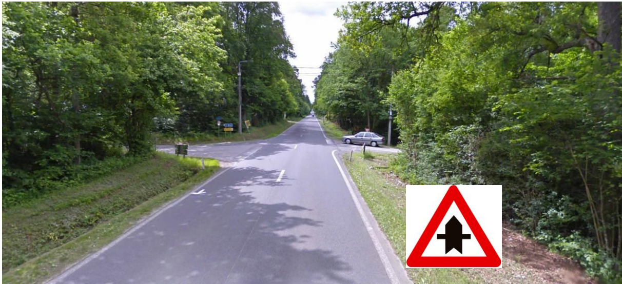
Figure 11 : La N86 à Erezée
