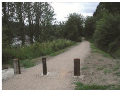
Empierrement fin compacté
