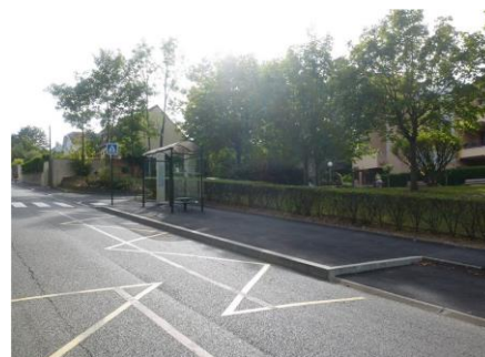
Arrêt en extension de trottoir dans le Pays de Limours (France)
