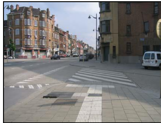
La dalle en caoutchouc indique l'arrêt de bus (position de la porte avant du bus arrêté)
