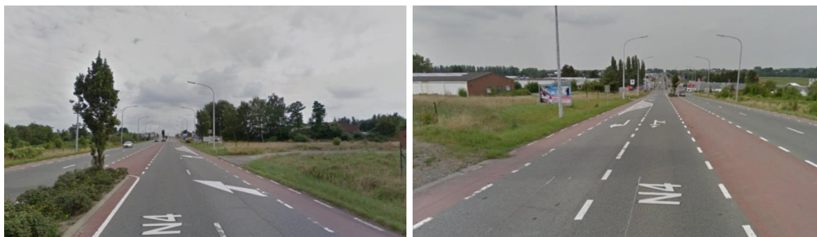
Exemple de ce type d'aménagement sur la N4 à Jambes
