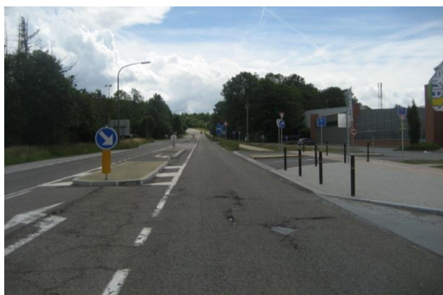
Entrée sécurisée sur la N86
