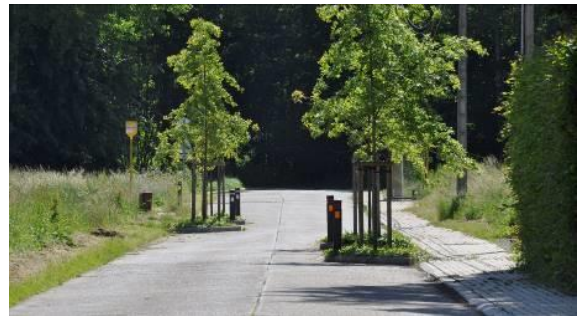
Photo 36 : Rétrécissement chicane (source : SPW, CeMathèque n°42, juin 2016)
