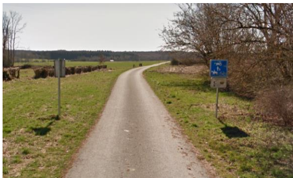
Photo 23 : Voirie réservée (F99) depuis la N83 à hauteur de Han (source : Google 2019)
