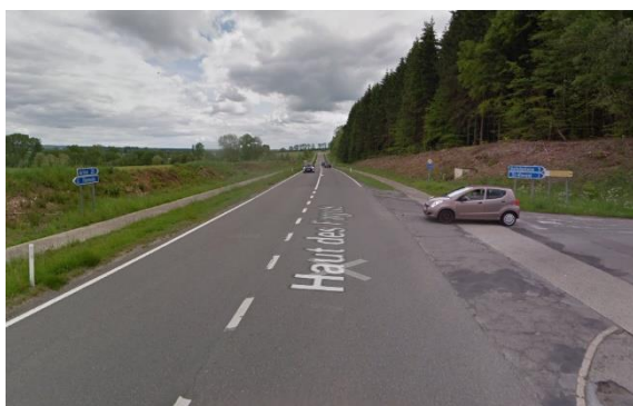
Photo 19 : Piste cyclable de la N83 à hauteur de Saint-Vincent (source : Google 2019)
