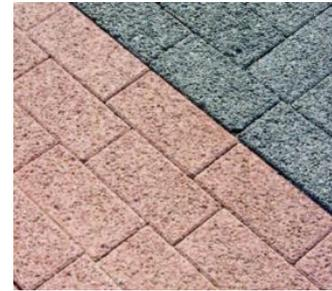
Figure 3. Revêtement drainant en pavés de béton poreux
