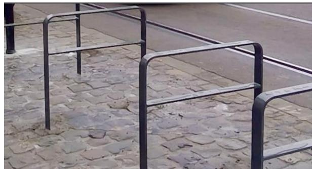
Figure 38 = modèle d'arceau en acier plat
