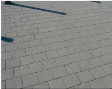
Figure 1. Revêtement modulaire en dalles de béton
