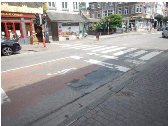
Photo 12. Chaussée en mauvais état (avenue du Pont, à Visé)
