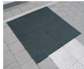
Figure 6. Revêtement en matériaux souples pour indiquer la présence d'une zone d'attente d'arrêt de bus
