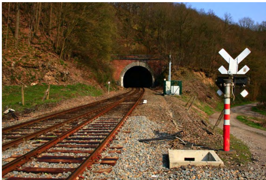
Figure 95 : tunnel de Jamioulx (source : TECHNUM)
