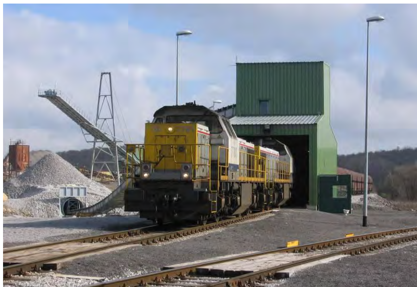
Figure 88 : chargement d'un train à la carrière "Les Petons" (source : Cédric Soltys)
