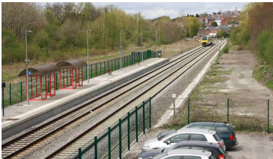
Figure 44 : à Berzée comme à Walcourt les quais ont été récemment rehaussés (source : TECHNUM)
