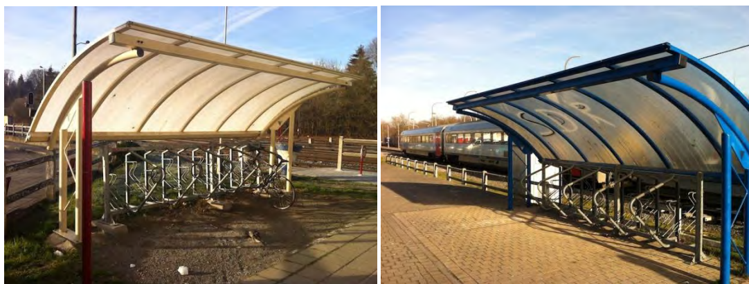
Figure 66: Abris pour vélos aux gares de Walcourt et Couvin
