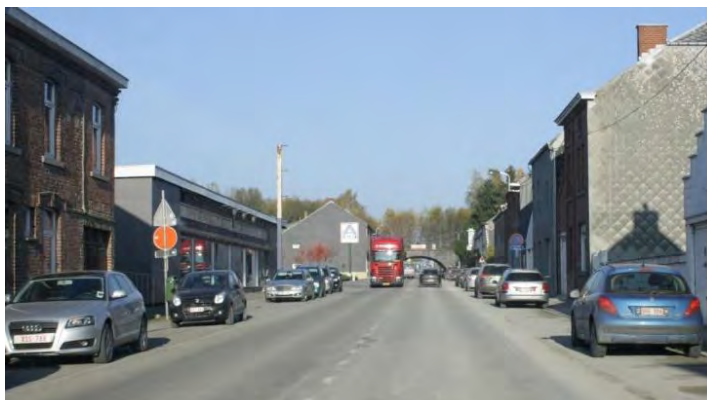
Figure 2: vue de la configuration actuelle de la N98 à Florennes (source : Technum)
