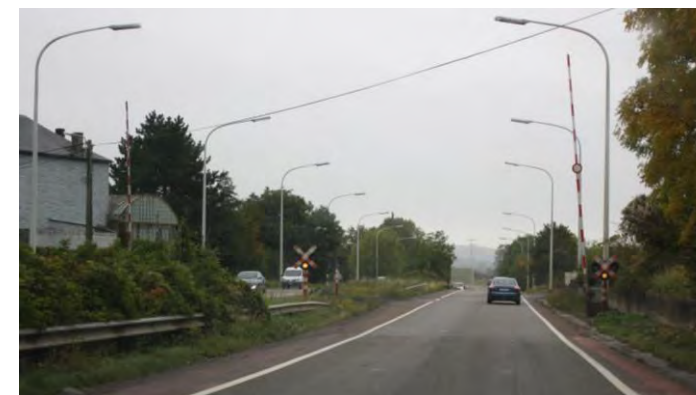
Figure 5 : vue du passage à niveau de Frasnes (source : Technum)
