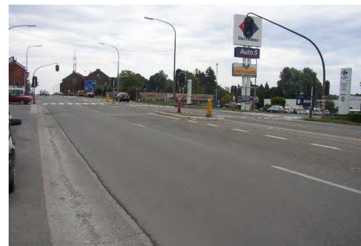
Figure 11 : vue du même endroit avant le réaménagement (source : http://boulevard.marche.be/ )
