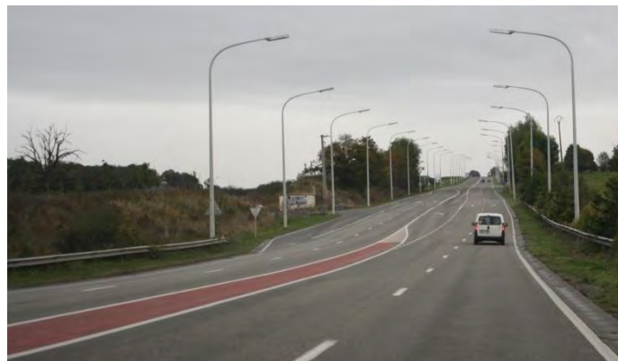
Figure 7 : la N99 entre Chimay et Couvin compte 4 à 5 bandes, une configuration largement sur-capacitaire qui favorise en outre la prise de vitesse (source : Technum)
