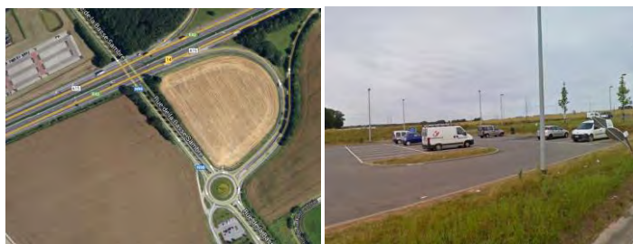
Figure 31 : Parking de covoiturage de Sambreville (E42 – N98)
