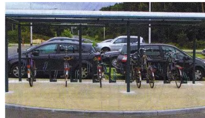
Figure 24 : Stationnement vélo dans un parking de covoiturage aux Pays-Bas (Source : Carpoolpleinen, Van beleid tot uitvoering, CROW, Publicatie 254, 2007)
