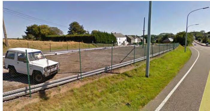
Figure 29 : Exemple de parking pouvant potentiellement être valorisé à des fins de covoiturage sur la N5-E420 à hauteur de Fraire
