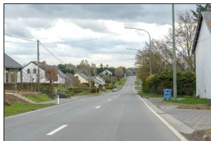
Photo 3 : Absence de trottoirs à Savy
