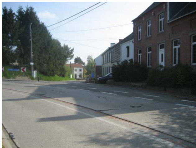
Accès gare - rue de Faux
