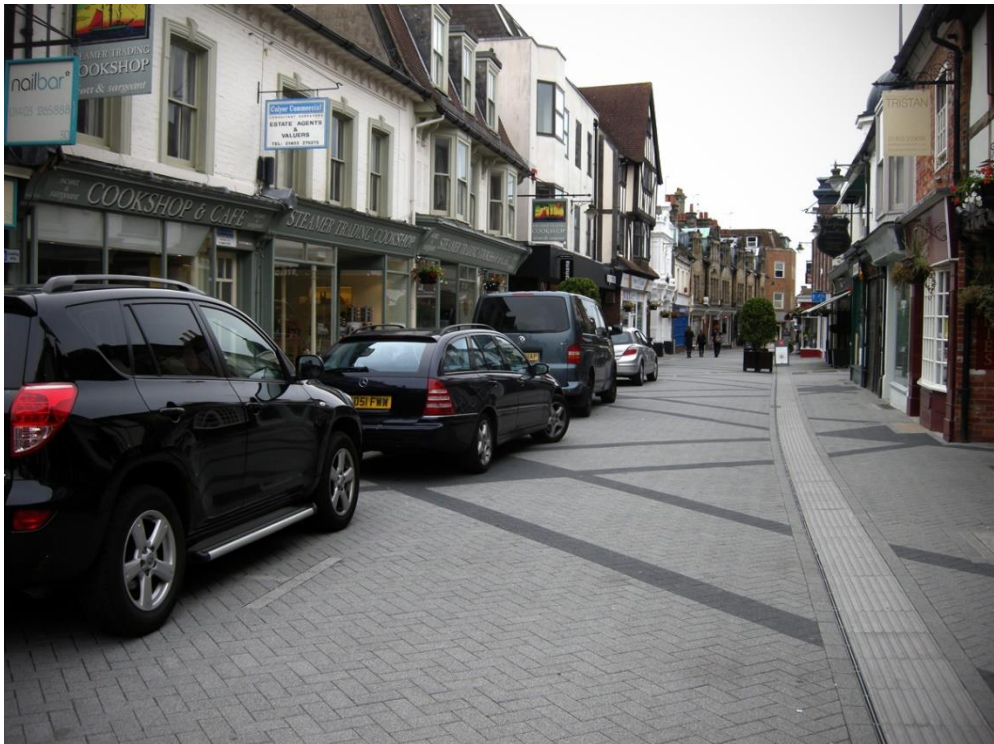
Figure 23 : Naked street dans East Street in Horsham, Sussex, UK – Le principe est d'ôter toute signalisation. Ce principe a été développé aux Pays-Bas et s'est exporté internationalement (source image : streetswithoutcars)
