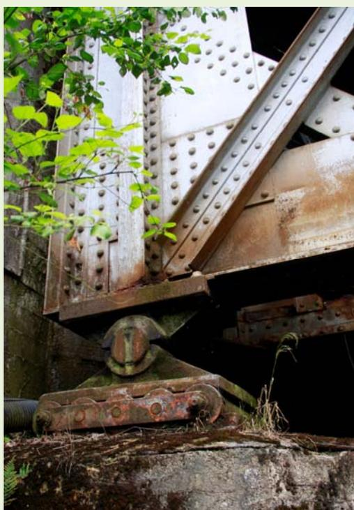
Figure 24 : vue des dégradations du pont de Hourpes sur la L.130A
