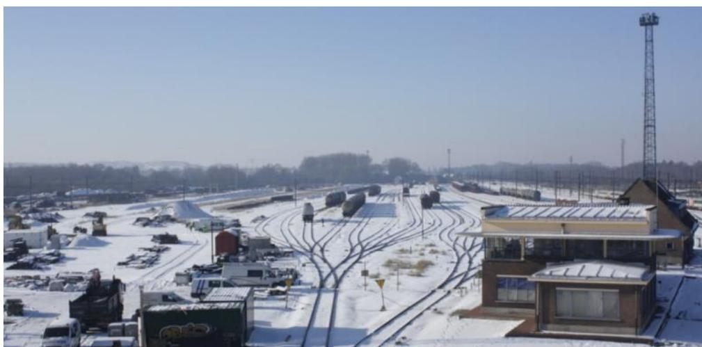
*Figure 41 : les grandes gares wallonnes (comme ici Saint-Ghislain) ont d'importants faisceaux de voies, mais qui sont souvent en mauvais état. L'enjeu est de reconfigurer et moderniser ces installations pour leur permettre de répondre de manière efficace aux besoins des opérateurs et des entreprises (source : Technum)*
