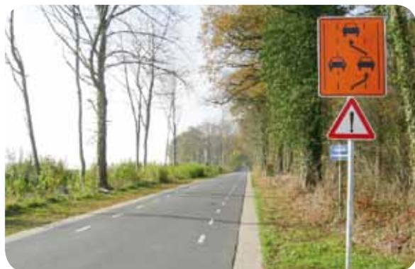
C'est là qu'intervient le concept de "Voies Centrales Banalisées" ou plus souvent "Bandes Centrales Banalisées" (BCB). Le principe en est simple : 2 marquages discontinus longitudinaux laissent un espace libre de 3 m au centre et dégagent des espaces d'environ 1,50 m en bordure de chaussée, praticables par les cyclistes. Les véhicules motorisés circulent au centre, sur une seule voie, et peuvent empiéter sur les bandes latérales lorsqu'ils croisent d'autres véhicules.
