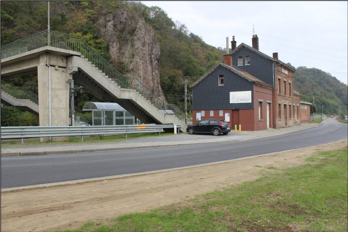
Figure 19 : Photo rue de Limite à Sclayn (Agora, 2021)
