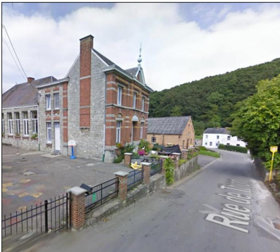
Figure 98 : Vue de la situation existante sur la rue de Thon
