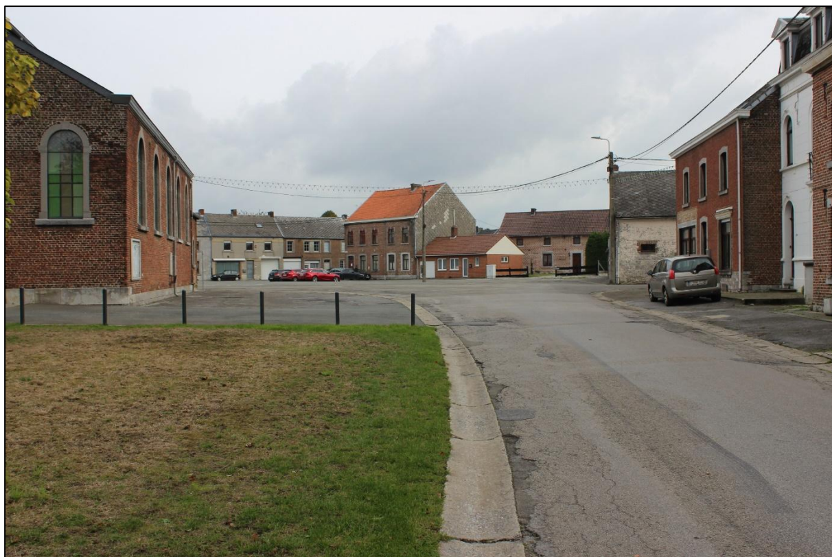
Figure 22 : Photo place Félix Moinil à Petit-Waret (Agora, 2021)
