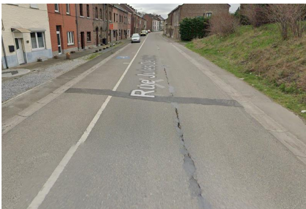
Figure 63 rue J. Destrée
