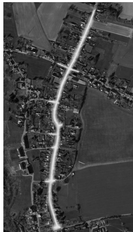
Figure 12: rue de Nivelles.
